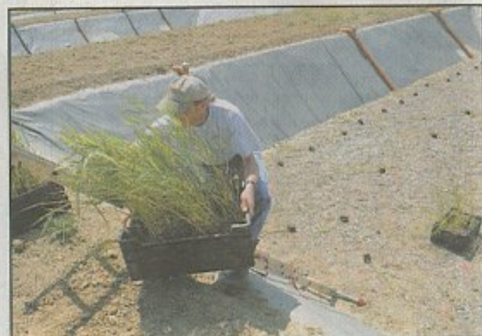
Hier, les volontaires ont planté 640 plants de roseaux qui s'occuperont de digérer les boues d'épuration dans la plus grande installation du genre en Suisse. ALAIN WICHT
