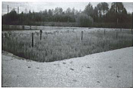
Station d'épuration de Certines (Ain-France), 3500 EH - 1800 m 2 de lits de séchage plantés de roseaux.
